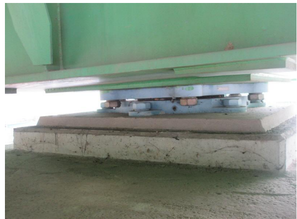
받침장치 상태양호 P2-SH1
