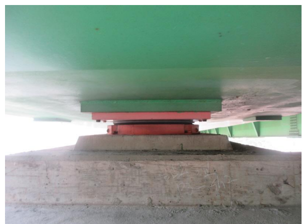
받침장치 상태양호 P3-SH2
